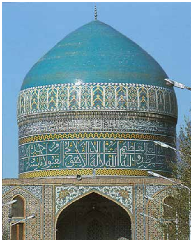
تصویر شماره ۳۲: نمای کلی بقعه از «سربایه‌های عمودی و کتیبه‌های افقی» از گلجین «معقلی بادبزی»، «پشت بغل‌سازی کاشی هفت‌رنگی»، «ایوان کاربندی»، «خط سه‌رگی بنایی»، «خط ثلث»، «قطاربندی» و... گنبد خواجه ربیع، مشهد (دوره صفویه)، مأخذ: نگارندگان
