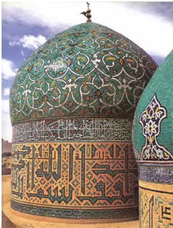
تصویر شماره ۲۷: «خط بنایی سه رنگی»، گنبدهای امامزاده ابراهیم بطحا (ع) و ابوالحسن زین العابدین (ع) مشهور به «هارون ولایت» اصفهان (دوره قراقویونلو) بازسازی دوره‌های بعد و معاصر،
