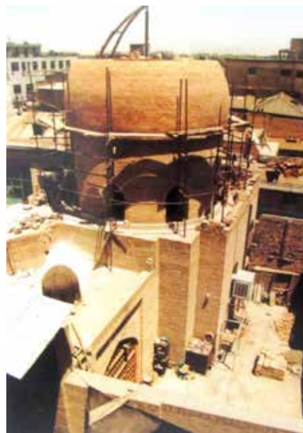
تصویر شماره ۱: پوشش گنبد در حال اجرا، بارگاه امامزاده محمد (ع)، خیابان طبرسی مشهد مقدس، بنا (دوره صفویه)، مأخذ: زمرشیدی، ۱۳۹۰
