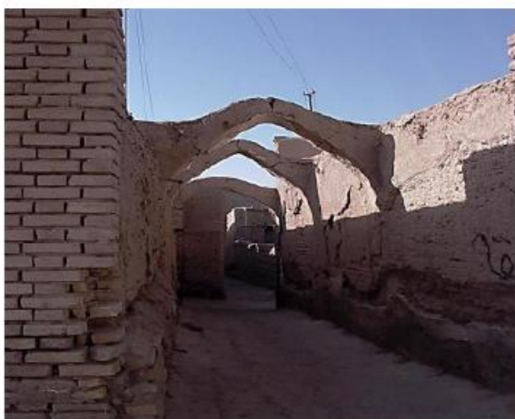
تصویر شماره ۵: نمونه‌ای از کوچه‌های مسقف و مهار بعضی از گذرها به وسیله تویزه‌های آجری ۹ ؛ مأخذ: آرشیو رحیم نژاد
