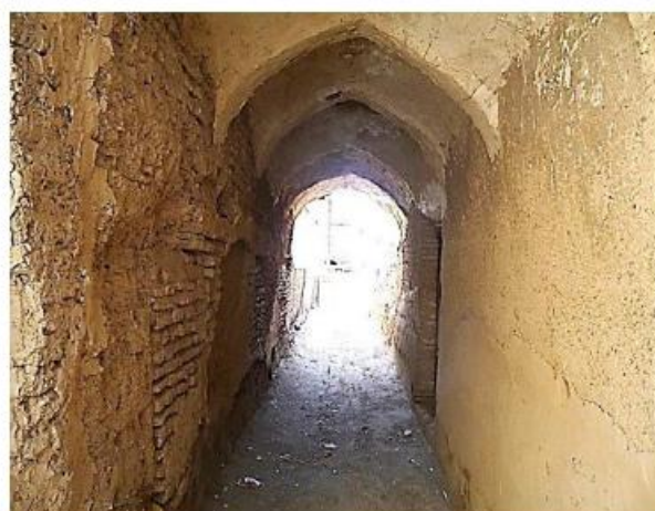
تصویر شماره ۵: نمونه‌ای از کوچه‌های مسقف و مهار بعضی از گذرها به وسیله تویزه‌های آجری ۹ ؛ مأخذ: آرشیو رحیم نژاد
