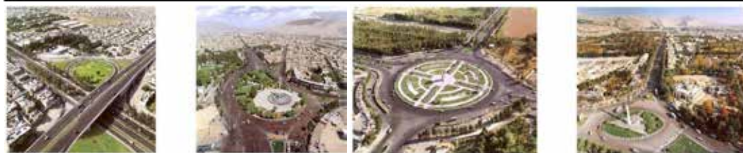
تصویر شماره ۶: در فلکه‌های میدان نام امروز، مرکز، مکانی برای آمیختگی فعالیت‌های موجود در بدنه‌ها نیست، بلکه جزیره‌ای در میانه است؛ تصاویری از فلکه‌های موجود در شهر شیراز؛ مأخذ: مهندسین مشاور شهر و خانه، ۱۳۸۸
