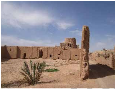
ب- محدوده باغ فیاضی در ضلع شرقی خانه فیاضی
