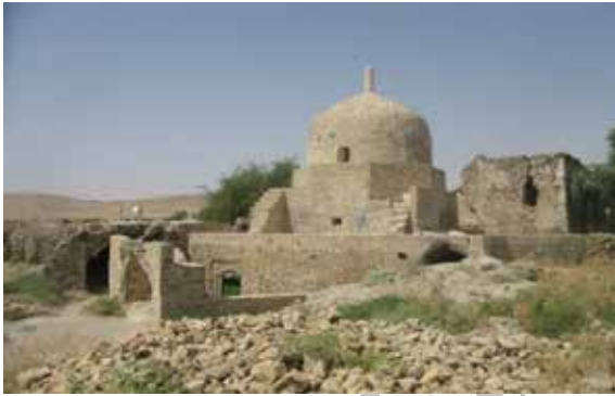
تصویر شماره ۹: استفاده از سنگ و گچ در بناهای بافت تاریخی دهدشت؛ ماخذ: نگارندگان
