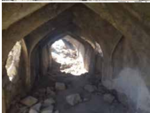
تصویر شماره ۱۱: کنترل نیروهای جانبی وارد شده بر بناها توسط سابات و بازار؛ ماخذ: نگارندگان
