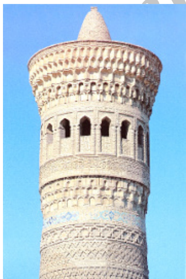
تصویر شماره ۷: هنرهای شگرف از آجرتراشی و آجرکاری: گردونه ساقه منقوش گلچین آجری، ستون‌های فلکه منقوش، پنجره‌سازی، قطار مقرنس‌های بی‌همتای آجری و... ناحیه انتهایی میل منار گلدسته «مسجد کلان» بخارا (دوره تیموری)؛ مأخذ: Pierre Chuvin SAMARKAND, BUKHARA, KHIVA
