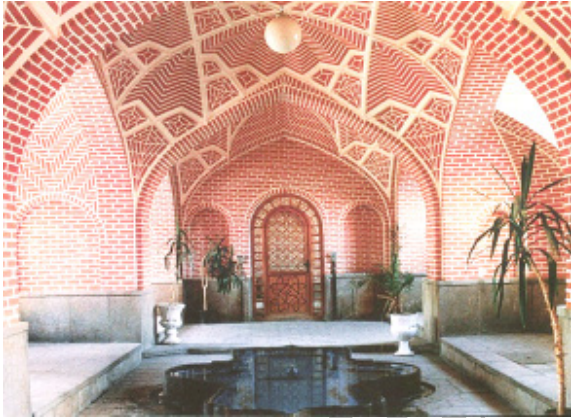
تصویر شماره ۱۰: نقوش آجری خفته و راسته و... در عناصر رسمی بندگی، حوض خانه منزل قدکی تبریز (دوره قاجاریه)؛ مأخذ: تصویر از آرشیو دانشگاه هنر اسلامی تبریز
