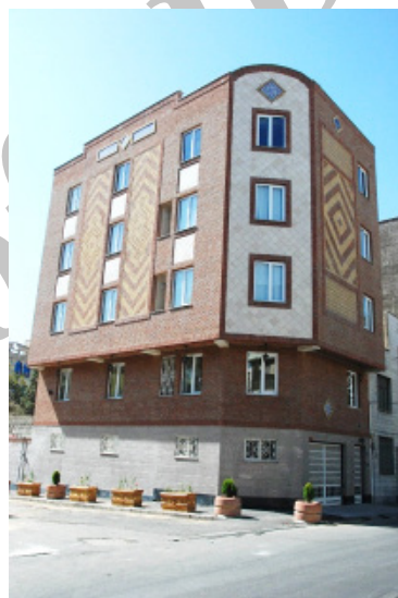
تصویر شماره ۱۲: کلیات نماسازی منقوش شامل: نقوش سم آهویی، کتیبه های منقوش آجر و کاشی، منقوش حصیری، خفته و راسته، قوس کلاله و... ساختمان سازی امروز؛ مأخذ: نگارندگان
