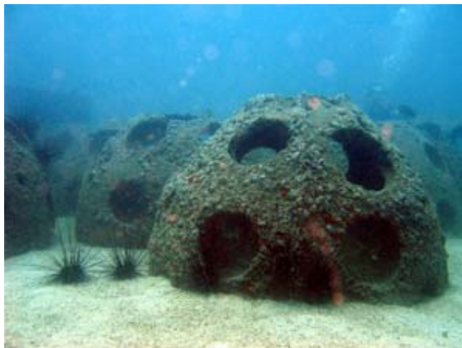
شکل ۱ - سازه های بتونی تشکیل دهنده زیستگاه مصنوعی ( منبع: www.reef-balls.com )
