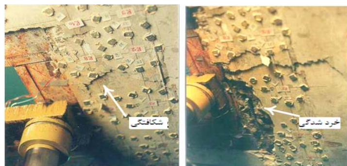
شکل ۱۵- شکاف خوردن (قبل از شکست) و خرد شدن بتن در هنگام شکست، نمونه S ۳ [۳].
