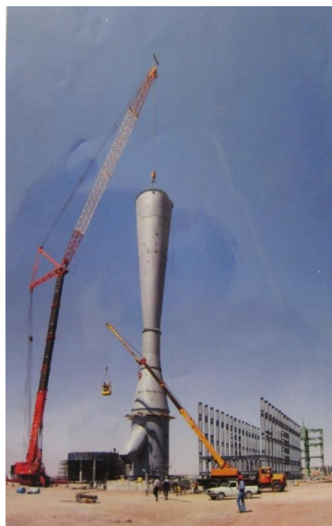
شکل ۱- جت اجکتور مادون صوت برای تخلیه گازهای حاصل از محصولات احتراق کوره صنایع فولاد ورودی سیال اولیه هوا
