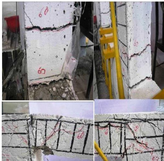
شکل ۸- نمایش آسیب کششی بتن و محل ترک‌ها در قاب [۱۸]
