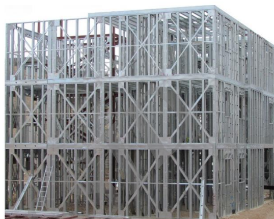
شکل ۱- ساختمان فولادی سرد نورد شده با مهاربند تسمه قطری
