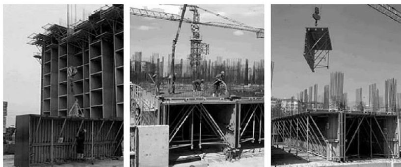
شکل ۱: اجرای سیستم سازه‌ای تونلی - فرم
