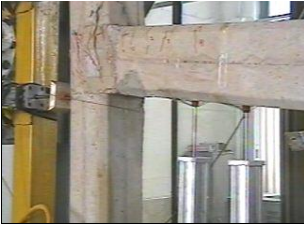
شکل ۴- ترکهای بر اتصال و هسته اتصال Base
