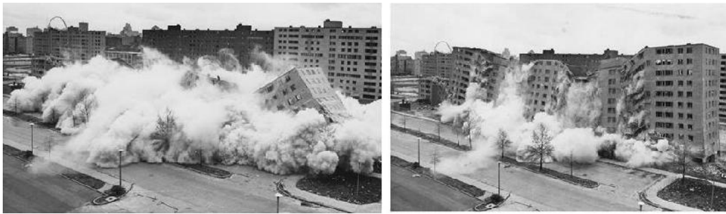
تصویر ۱. لحظه انهدام ساختمان‌های پروئیت ایگو منبع: en.wikipedia.org/wiki/File:Pruitt-igoe_collapse-series.jpg
