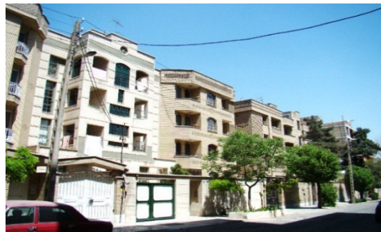
تصویر ۴. بالکن‌های اجرا شده در پخ ۴۵ درجه
