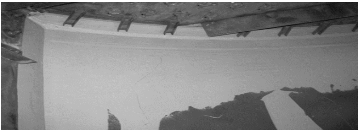
شکل ۸- اعمال پوشش‌های چسب سرامیک بر روی سطح داخلی برج احیاء آمین
