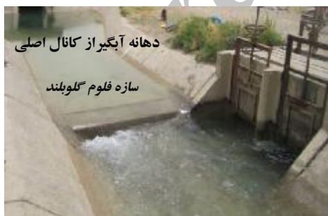
شکل 2- نمونه‌ای از سازه نهر پایه‌دار گلوبلند موجود در شبکه آبیاری درودزن (ابتدای نهر T19).
