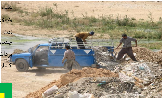
شکل (۷) تخلیه زباله‌های ساختمانی در ساحل راست و قبل از تلاقی بشار با شاخه مهربان
