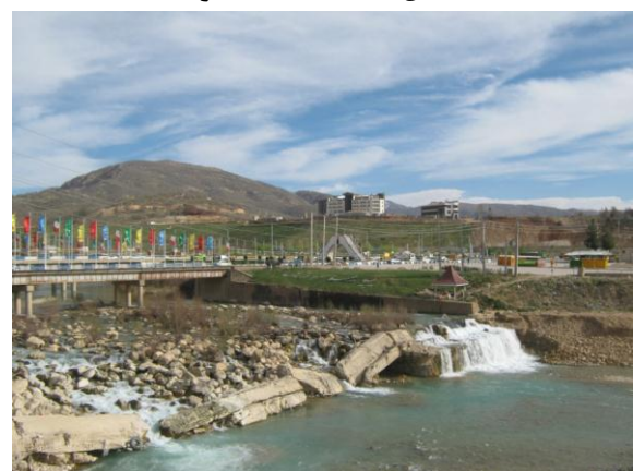
شکل (۳) ایستگاه پل بشار
