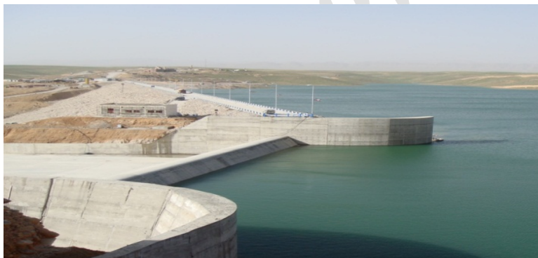
شکل ۳- نمای کلی سرریز سد ملاصدرا
