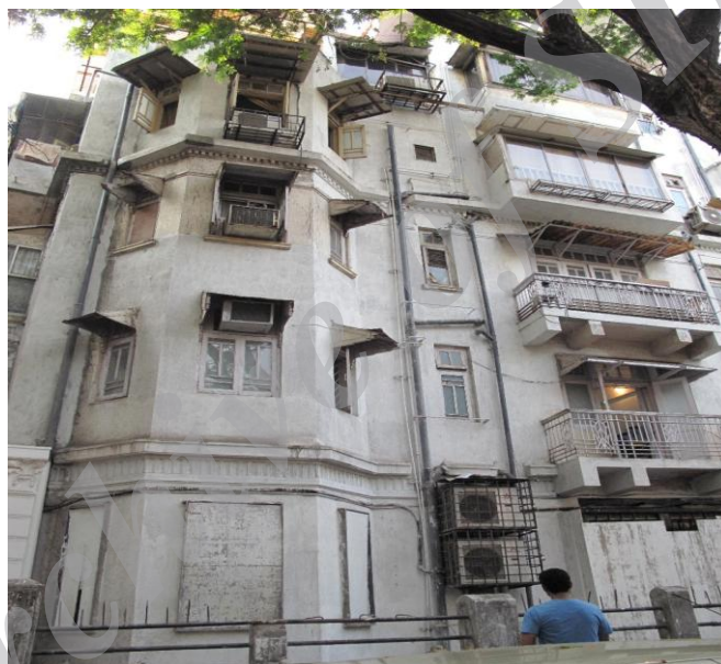
تصویر ۳ ساختمان سامر کویین
