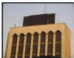
نقطه قوت: تناسب تابلو نصب شده با عرض بام ساختمان
