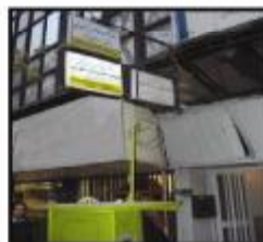
نقطه ضعف: اتصال چند تابلو به یک میله در جلو کاربریها با اتصالات نامناسب
