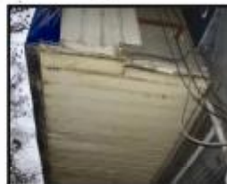
نقطه ضعف: عدم اتصال صحیح تابلوها و عدم استفاده از مصالح با دوام
