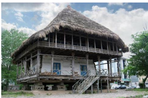
شکل ۸. نحوه ارتباط ساختمان با زمین در خانه سنتی شمال کشور مأخذ: http://photos.wikimapia.org/p/00/01/96/19/37_big.jpg
