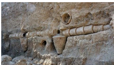
شکل ۷. استفاده از ظروف سفالین در سیستم آبرسانی ارگ قدیم بروجرد مأخذ: خبرگزاری تسنیم https://www.tasnimnews.com/fa/news
