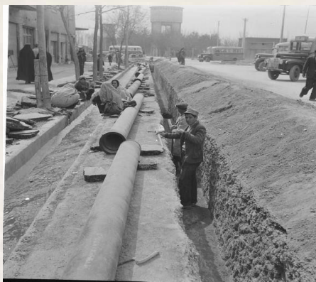
شکل ۳. لوله‌کشی آب شهر تهران، سال ۱۳۳۰. 61
