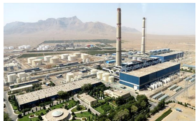
شکل ۲. نمایی از دودکش‌های نیروگاه شهید منتظری اصفهان Fig. 2. An upper view of the Montazeri Power Plant
