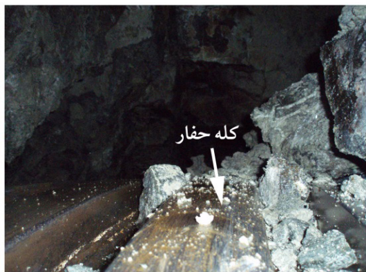
(ب) فضای خالی در اطراف کله حفار و ریزش مصالح بر روی آن
