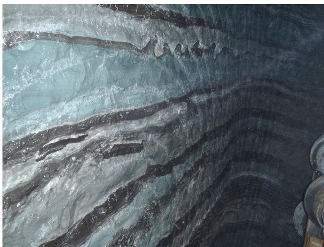
شکل ۶: وضعیت لایه‌ای توده‌سنگ در مترای ۱۲۷۱۷ m Fig6 - Rock mass bedding condition at 12717m chainage
