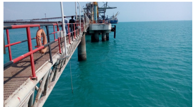
شکل ۲. نمای بخش شرقی اسکله فولاد
