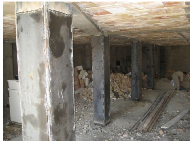
شکل ۱. مقاوم سازی ستون‌های سازه با ژاکت فولادی
