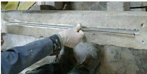
شکل ۳. قرار گرفتن مصالح مقاوم کننده درون شیار
