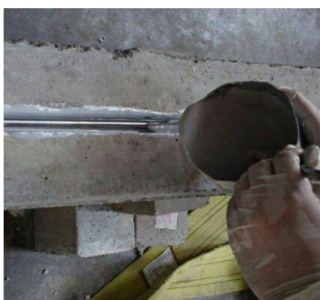
شکل ۴. پر کردن شیار با رزین
