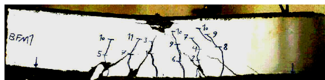
شکل ۸. وضعیت نمونه‌ی BFM1 پس از پایان بارگذاری Fig. 8. Crack propagation in specimen BFM1
