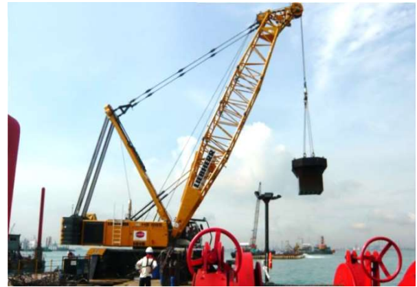
شکل ۱۲: عملیات تراکم دینامیکی فراساحلی با استفاده از جرثقیل با ظرفیت باربری بالا و شناور [۱]
