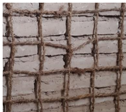
شکل ۴. نحوه ی مهار مش با طناب الیاف خرما Fig. 4. Lateral restraint of palm meshes with palm tie
