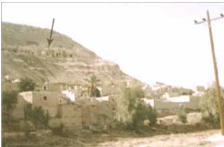
شکل ۸: ناپایداری دامنه ها و ریزشی بودن آن در دامنه کوه قلعه تاریخی ازدها پیکر
