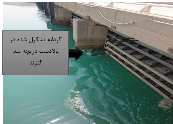
شکل ۱. گردابه تشکیل شده در پشت دریچه سد
