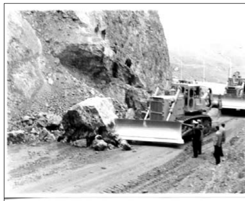
شکل ۱- پاک کردن سطح راه و رفع انسداد ناشی از ریزش سنگ در گردنه صلوات آباد سنندج
