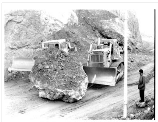
شکل ۱- پاک کردن سطح راه و رفع انسداد ناشی از ریزش سنگ در گردنه صلوات آباد سنندج
