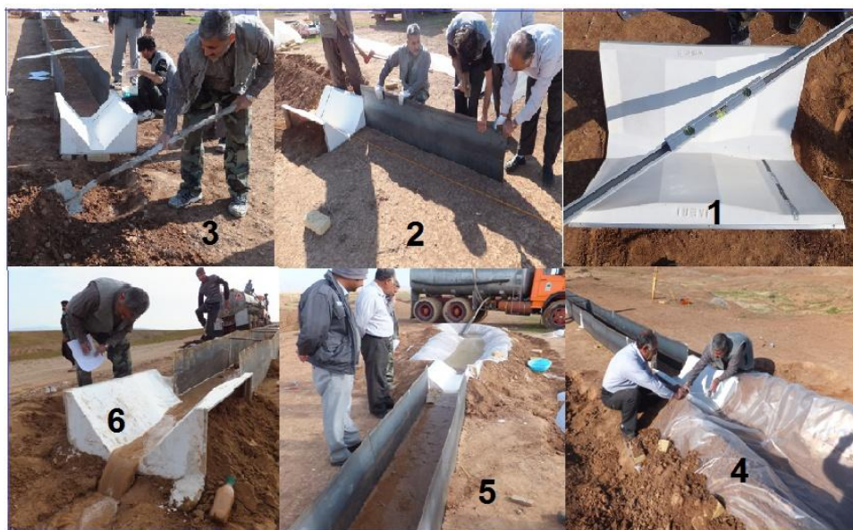
شکل ۲. مراحل نصب پلات صحرائی به ترتیب (۱) - نصب فلوم (۲) - نصب دیواره پلات صحرائی (۳) - پایاب (خروجی جریان) و محل نمونه برداری رسوب، (۴) - کانال نفوذ ناپذیر قبل از ورود جریان، به منظور ایجاد جریان یکنواخت (۵) - اشباع خاک و جریان هیدرولیک (شبهه سازی برای تعیین آستانه‌های هیدرولیک)، (۶) - فلوم انتهایی به منظور اندازه گیری دبی خروجی و رسوب
