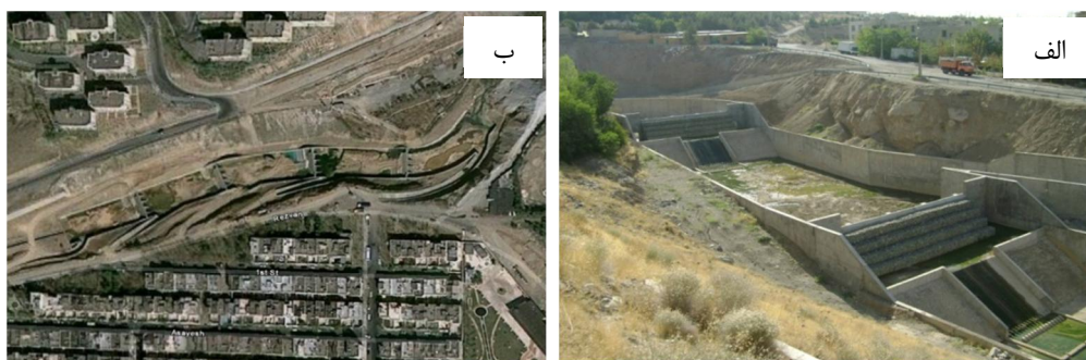
شکل ۴- حوضچه رسوب‌گیر در زهکشی شهری واقع در دارآباد، الف) از جلو، ب) از بالا
