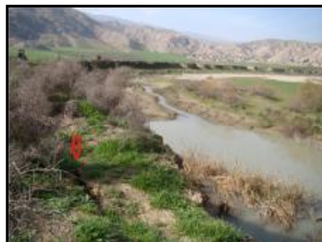
شکل ۱- فرسایش سواحل رودخانه‌ها (رودخانه سیمره - شهرستان سیروان)
