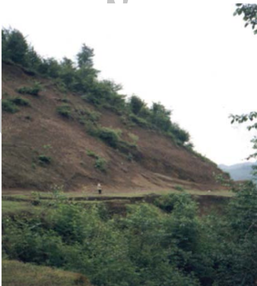
شکل ۳- جاده‌سازی عامل دیگر زمین لغزش در منطقه است.
