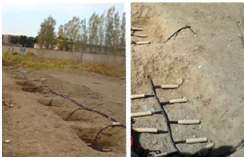
شکل ۱- نحوه کارگذاری کپسول‌های رسی متخلخل در عمق ۴۰ سانتی متری و فواصل ۱۵ سانتی متری.
