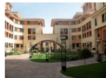
شکل ۲. بخشی از محوطه مجتمع زیتون
