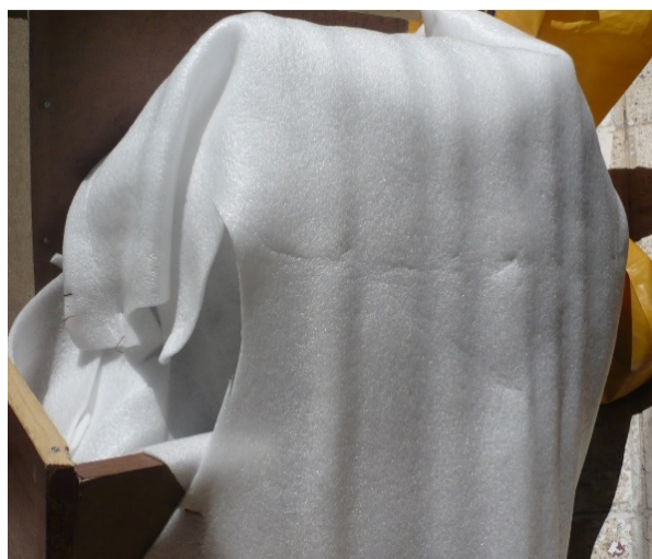
شکل ۱۱. پوشاندن سامانه با فوم برای عایق سازی
