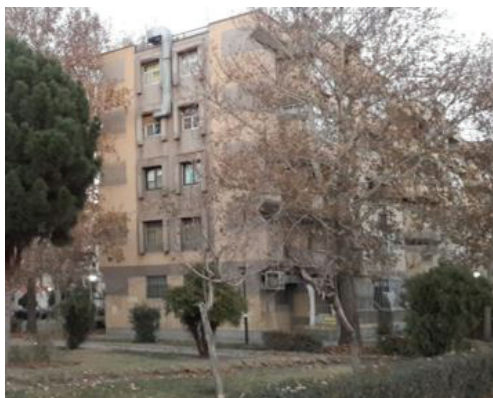
شکل ۵. فضای باز و ساختمان های مجموعه
