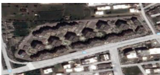
شکل ۳. دید هوایی از مجتمع سعیدیه (مأخذ: معاونت پژوهش و تحقیقات اداره کل مسکن و شهرسازی استان همدان، ۱۳۸۹)
