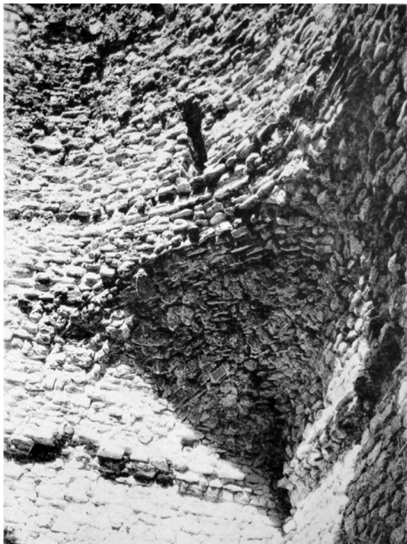
تصویر ۵- آتشکده فیروزآباد (در برخی منابع کاخ اردشیر)، گوشه‌سازی زیر گنبد اصلی برای اتصال میان دایره و مربع در پلان. ماخذ: (آپم پوپ، ۱۳۸۸، ۱۴۶)
