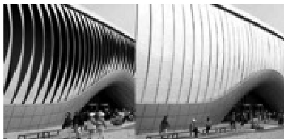
تصویر ۶- نمای تغییرپذیر تماتیک پابیون (Thematic Pavilion) در آکسویو ۲۰۱۲ در شهر یئوسو در کره جنوبی که توسط شرکت سازه‌های کنیپرز-هلبیگ (Knippers Helbig Advanced Engineering) توسعه یافته است. این نما بطور غیرمستقیم ملهم از مکانیزم فلکتوفین است اما در جزئیات با آن تفاوت‌هایی دارد. مأخذ: (Lienhard, 2012)
