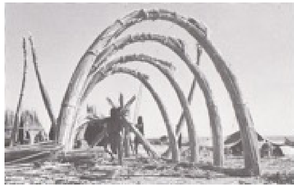
تصویر ۱- سازه خم‌شو از جنس بامبوهای دسته شده مربوط به فضای عمومی روستایی در گینه نو. مأخذ: (Rudofsky, 1987, 127).
