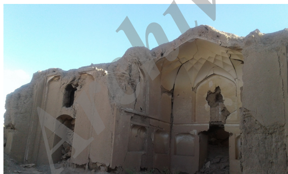
تصویر ۳- سمت راست: نمونه‌ای از پلان یک خانه مسکونی در فردوس قدیم. سمت چپ: بقایای ایوان تابستان نشین. مآخذ: (طرح بسیج توان فنی کشور
