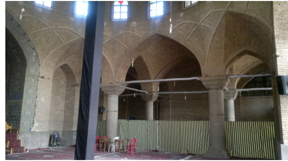
تصویر ۱۰- برپایی گنبدخانه مسجد رحیمخان بر ستونهای سنگی.
