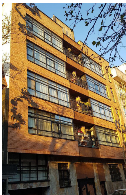
تصویر ۱- نمای کلی ساختمان (دید شمال شرقی).
