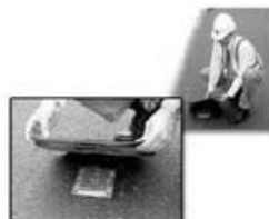
ج - شیوه اجرای نصب دستگاه تردد شمار سیار NC-97
