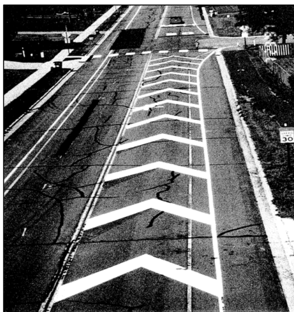
شکل پنج: نحوه اجرای پیکان‌های ۷ شکل را در یک بزرگراه و قبل از تقاطع نشان می‌دهد.
