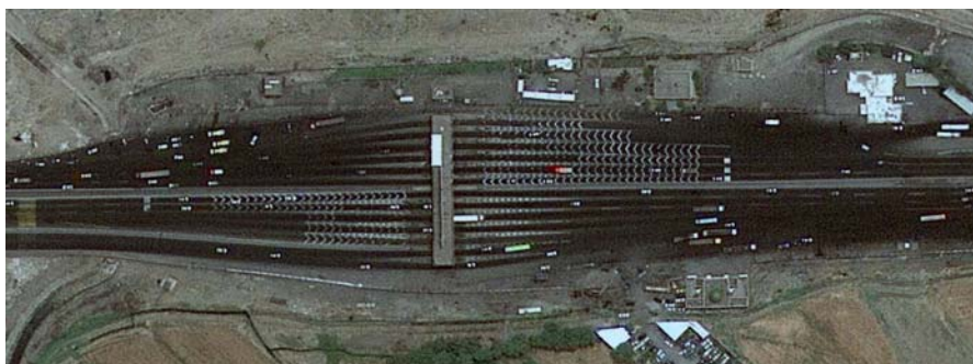
شکل هفت: پیکان‌های ۷ شکل اجراشده در عوارضی کرج
