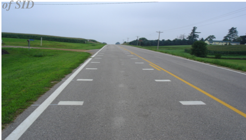
شکل دو: خط‌کشی عرضی که با فواصل همگرا خط‌کشی می‌شود (Bryan.J,2004)
