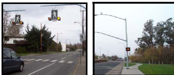
شکل چهار: نمایی از چراغ چشمک‌زن فانوسی برای ایجاد توجه برای راننده وسیله نقلیه (ابوالحسن نژاد، ۱۳۸۵).
